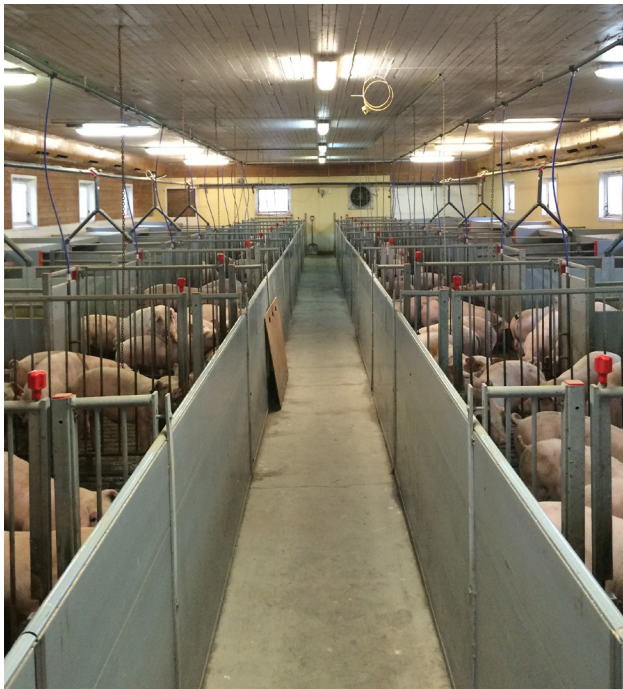
Dritter Betrieb: Einraumstall aus Holz, isoliert, Teilspaltenboden mit Betonrosten parallel zum zentralen Treibe- und Versorgungsgang. Flüssigfütterung am Langtrog.
