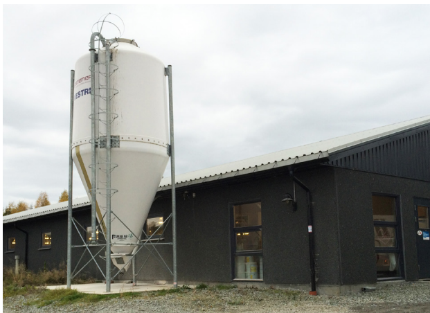
Neubau 2013, Abferkelstall mit 52 Buchten in einem Raum, Büro mit Übernachtungsmöglichkeit, verglaster Besuchergang
